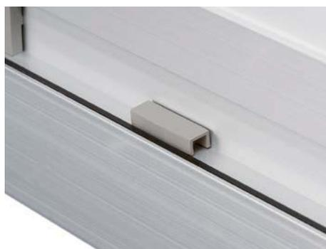
結露排水弁(片引き窓 FIX部)
