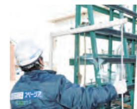
スペーシアの取り替え工事は、もともとのサッシを活かしてガラスを取り替えるだけなので、とても簡単です。スペーシアをサッシに固定する際、シーリング材の代わりに取付専用グレチャンが使える場合では、ガラス1枚あたり約30分で取り替えできます。
